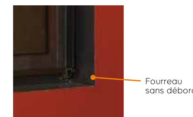
Le bord du fourreau vient affleurer le bord du coffrage.
